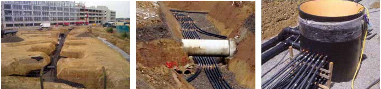
Figure 11 Photos de terrassement et de pose de réseaux de connexions d'un champ de SGV - © Burgeap
