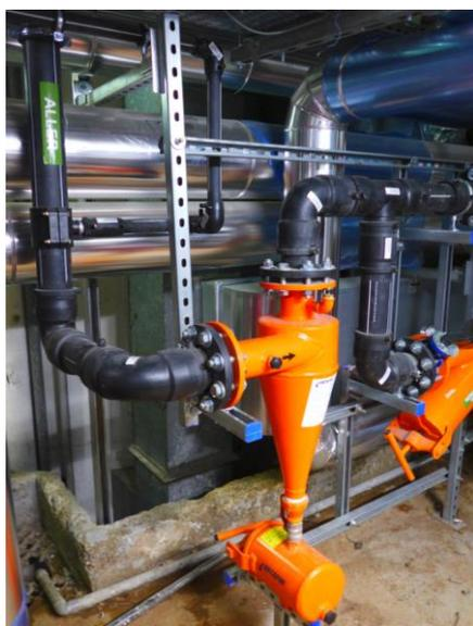
*Exemple de filtre cyclonique et filtre à tamis*
