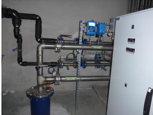
*Exemple d'équipement d'un forage d'injection équipé en retro lavage*
